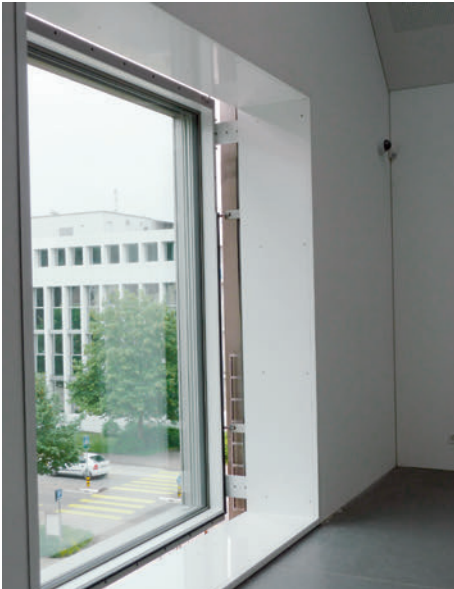
Ein Parallel-Ausstellfenster - als Kastenfenster gebaut - im geöffneten Zustand. Gut zu erkennen sind die vier teleskopartigen Auszugsbeschläge. Auf ihnen lagert das gesamte Flügelgewicht. Une baie ouvrante parallèle, construite en fenêtre à caisson, en position ouverte. Les quatre ferrures télescopiques se distinguent nettement. Elles supportent tout le poids du vantail.
