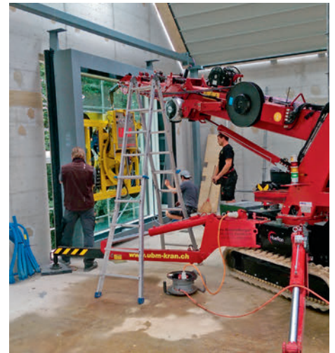
Nachdem die Fensterelemente von oben an den Zielort gehievt waren, folgte die Endplatzierung mit dem Glaslift, ausgerüstet mit einer Vakuumsauganlage.
