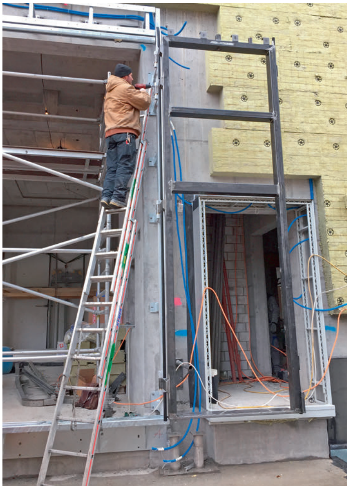
Montage des Grundrahmens. Auch die Flügel sind zu Ausrichtungszwecken provisorisch eingehängt worden. Montage du cadre de base. Même les vantaux ont été accrochés provisoirement pour être ajustés.
