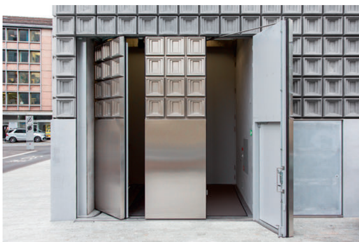
Der rechte Flügel ist als Drehflügel, die beiden anderen sind als Schiebe- flügel ausgebildet.
