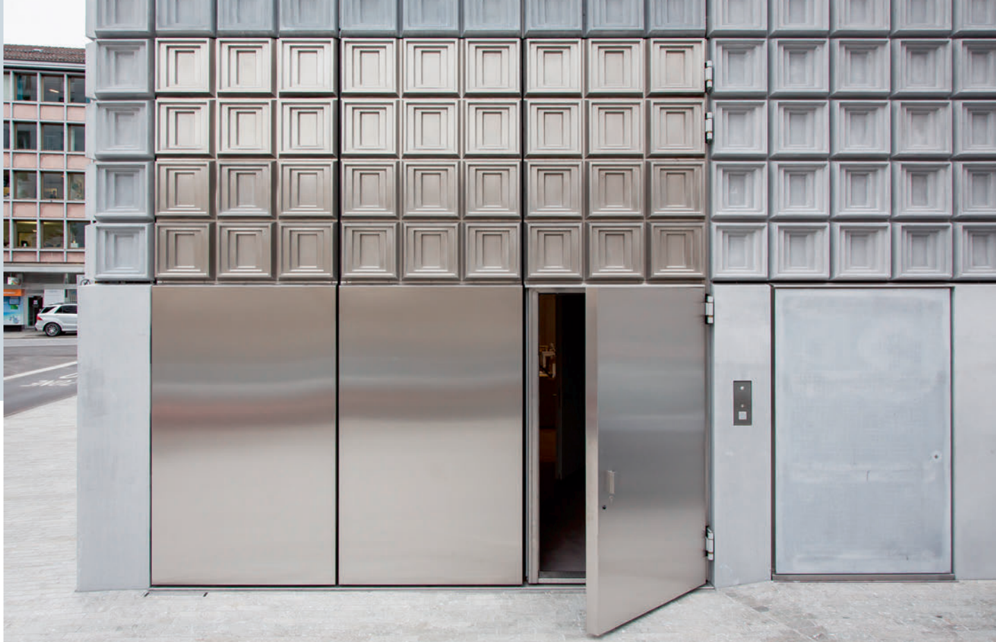
Die rhythmische Anordnung der reliefartigen Quadrate von 487 × 487 mm, wird von der Betonfassade über die Toranlage weitergeführt. Le motif des carrés en relief de 487 × 487 mm de la façade en béton est reproduit sur le portail.
