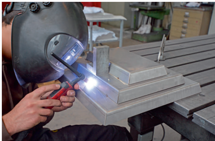
Schweissen der 36 Blechlachelemente. Soudage des 36 carreaux en tôle.
