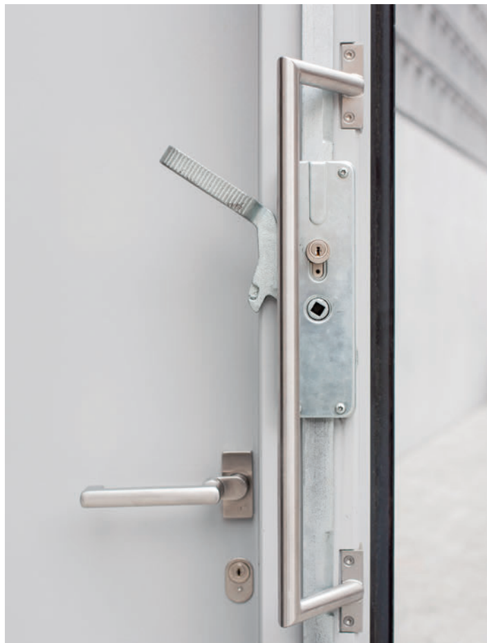
Ziehgriff und Verriegelungsmechanismus. Poignée de traction et mécanisme de verrouillage.
