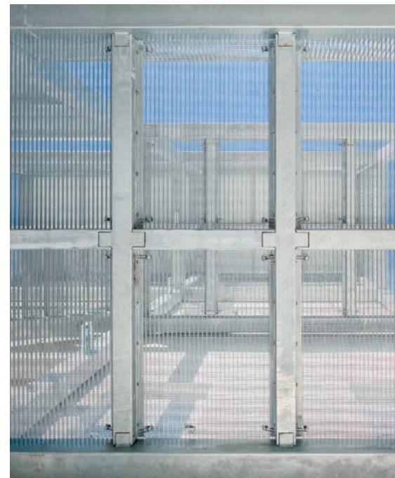
Untersicht der Podeste. Auch die Fügungen der Stahlbauprofile dürfen sich sehen lassen.
