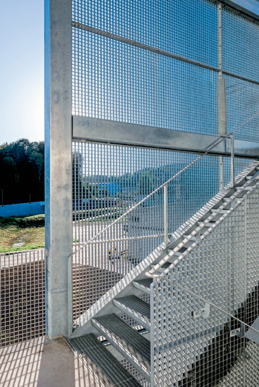
Die Vollroste bestehen aus Flachstahl 40 × 4 mm, die Querstäbe aus Flachstahl 40 × 3 mm.
