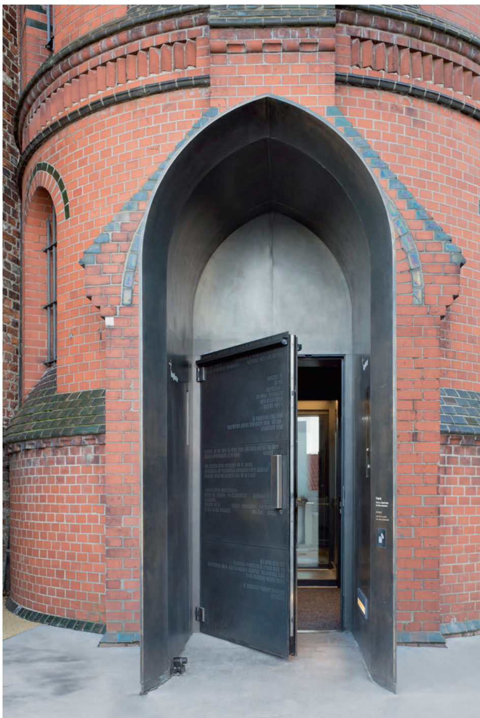
Das denkmalgeschützte Burgkloster erhält einen neuen Eingang. Der Spitzbogenvorbau ist ebenso wie die flächenbündig eingebrachte Automatiktür (Janisol) mit Baubronze verkleidet.
