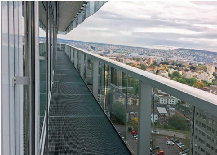
**Bild 11:** Längsblick in die Serviceschicht mit den Kammrosten, Geländerpfosten, dem breiten Handlaufprofil in Aluminium, der Streckmetall-Untersicht und den aufgehängten VSG-Scheiben.
