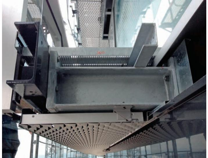
**Bild 10:** Einblick in die offene Bodenkonstruktion der Serviceschicht im Bereich der kleinsten Ausladung.
