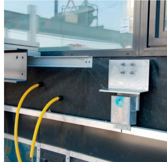
**Bild 8:** Gedämmter und mit diffusionsoffener Folie abgedichteter Deckenstirnbereich mit Stahlkonsole unmittelbar vor der Montage der Serviceschicht.
