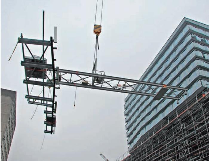
**Bild 9:** Der am Baukran hängende Lastbalken mit verschiebbarem Gegengewicht (rechts). Links am Lastbalken aufgehängt ein Segment der Bodenstruktur mit Geländerpfosten und aufgestapelten Gitterrosten.
