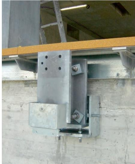
**Bild 7:** Fertig verschraubte und in allen drei Dimensionen justierte Serviceschichtkonsole. Oben das auf die T-Konsolen montierte Fensterauflageprofil.
