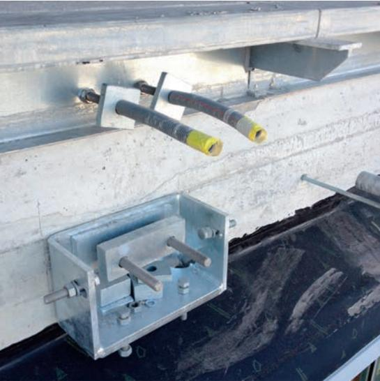
**Bild 6:** An der Decken-Oberkante einbetoniertes, durchlaufendes Stahlblechprofil mit T-Konsolen und den oberen Ankerstangen. An die unteren, ebenfalls einbetonierten Ankerstangen ist bereits der Auflageschuh mit Stellschrauben für die Serviceschichtkonsolen montiert.
