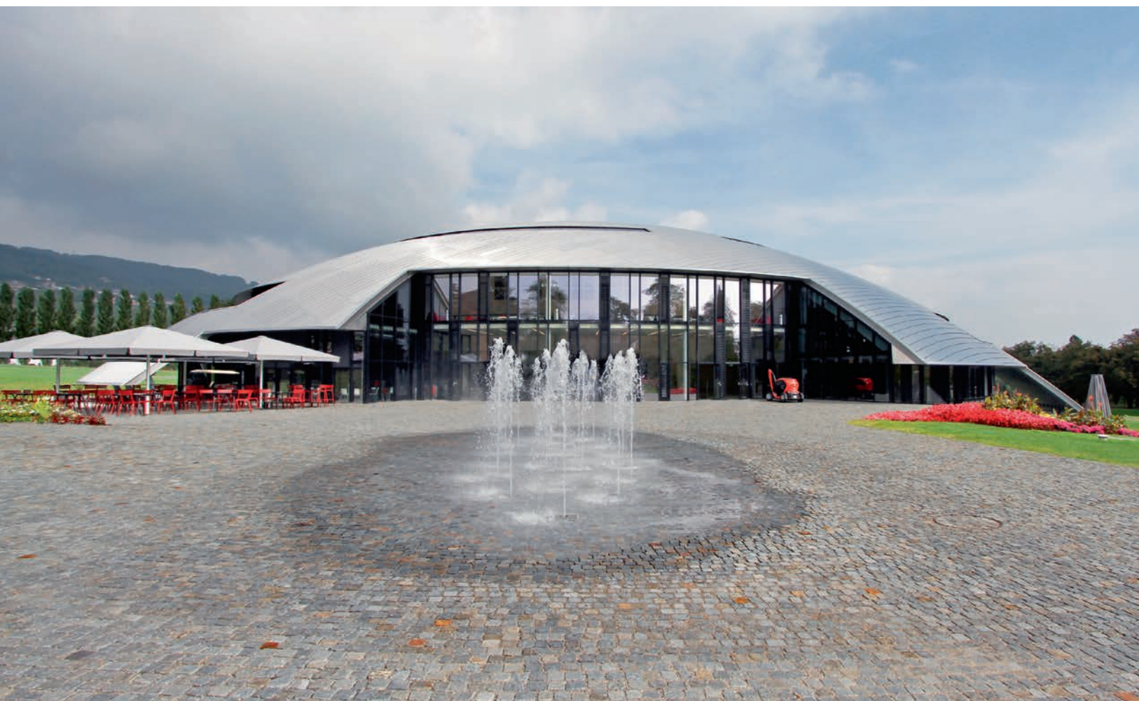
Das 4900 Quadratmeter überspannende Edelstahldach wird von einem 570 t schweren Unterbau getragen. Le toit en acier inoxydable qui recouvre 4900 m 2 est supporté par une assise de 570 t.
