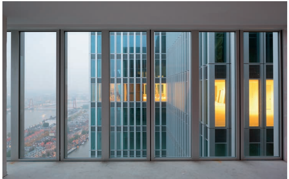
Innenansicht: abwechselnd Elementverbindung und verstärkter Pfosten. Vue depuis l'intérieur : les liaisons entre éléments alternent avec les poteaux renforcés.
