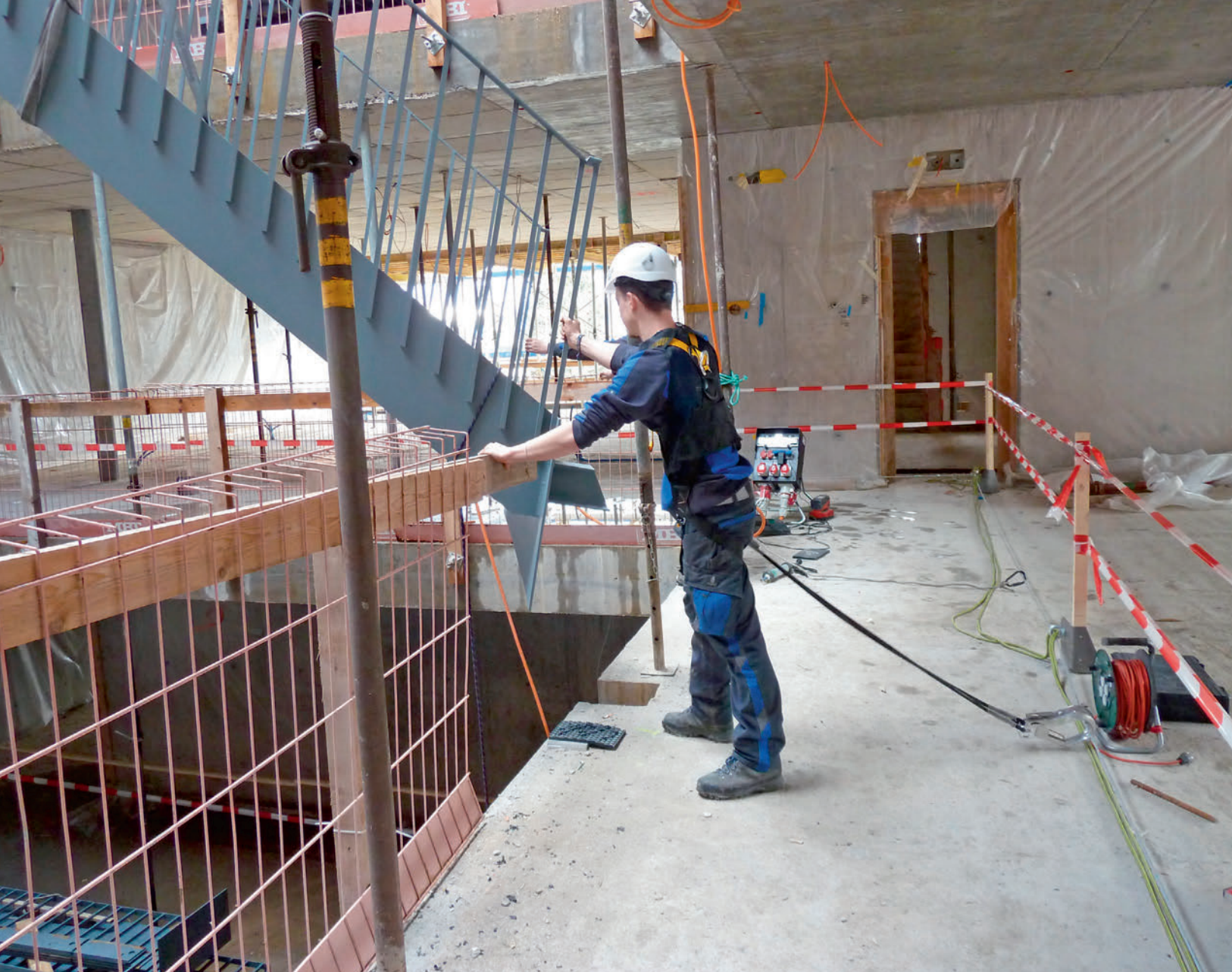
Treppenmontage an der offenen Kante. Seriös geplante Sicherheitsmassnahmen ermöglichen ein uneingeschränktes, sicheres Arbeiten. Montage de l'escalier du côté ouvert. Des mesures de sécurité planifiées avec sérieux permettent de travailler de manière sûre et sans contrainte.
