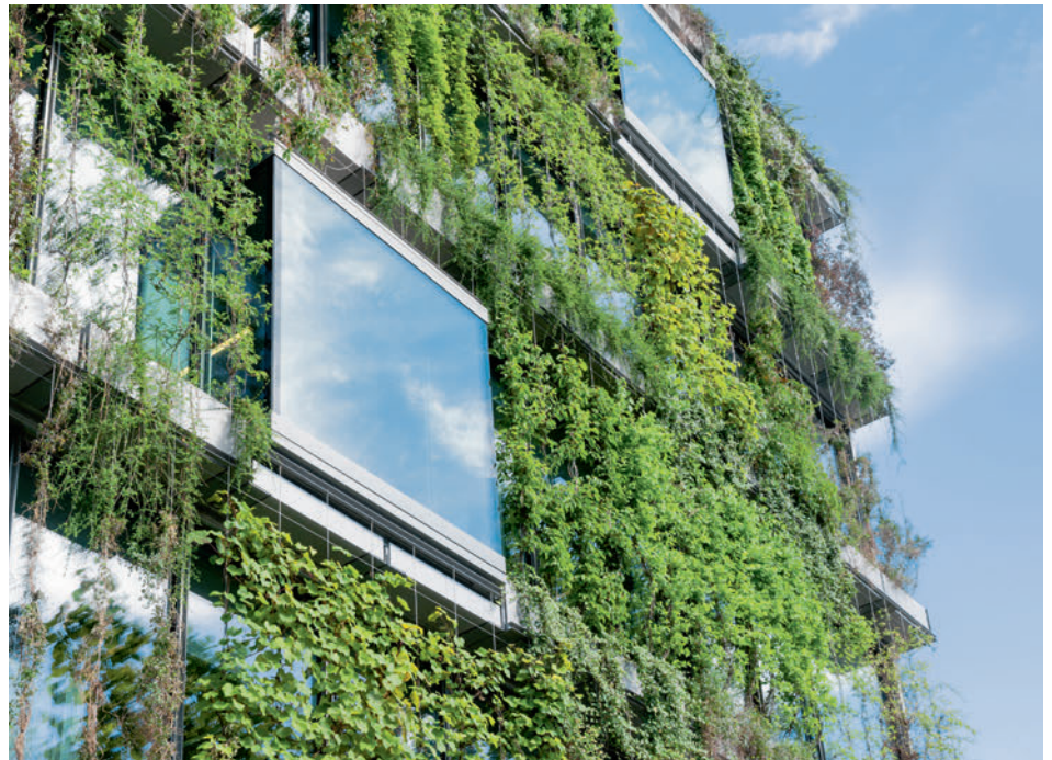
100 aufgehängte, horizontal verlaufende Pflanztröge à 800 Kilogramm für eine lebendige Fassade. Cent bacs à plantes suspendus de 800 kg chacun disposés horizontalement rendent la façade vivante.
