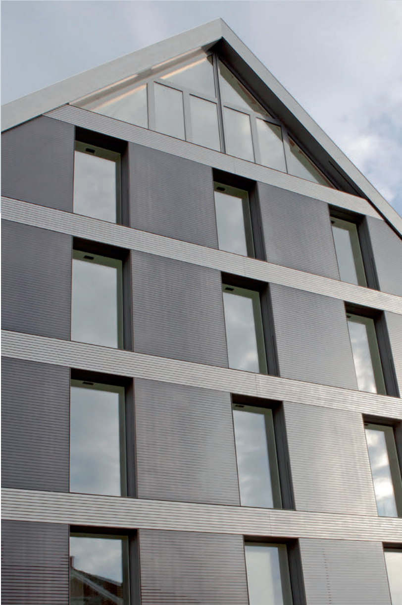
Die fertiggestellte Solarfassade am Mehrfamilienhaus in Aesch. La façade solaire terminée de l'immeuble plurifamilial à Aesch.
