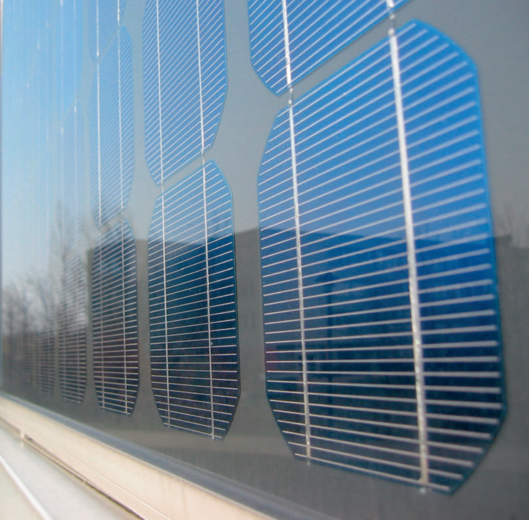
Typische, in die Fassade integrierte PV-Schicht. Revêtement PV ordinaire, intégré à la façade
