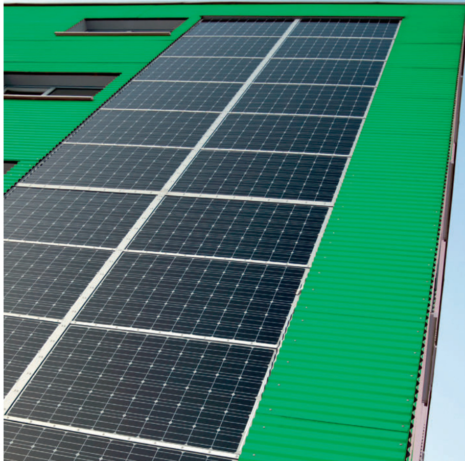
Photovoltaik in Kombination mit einer hinterlüfteten Fassade. Photovoltaïque combiné à une façade ventilée par l'arrière.
