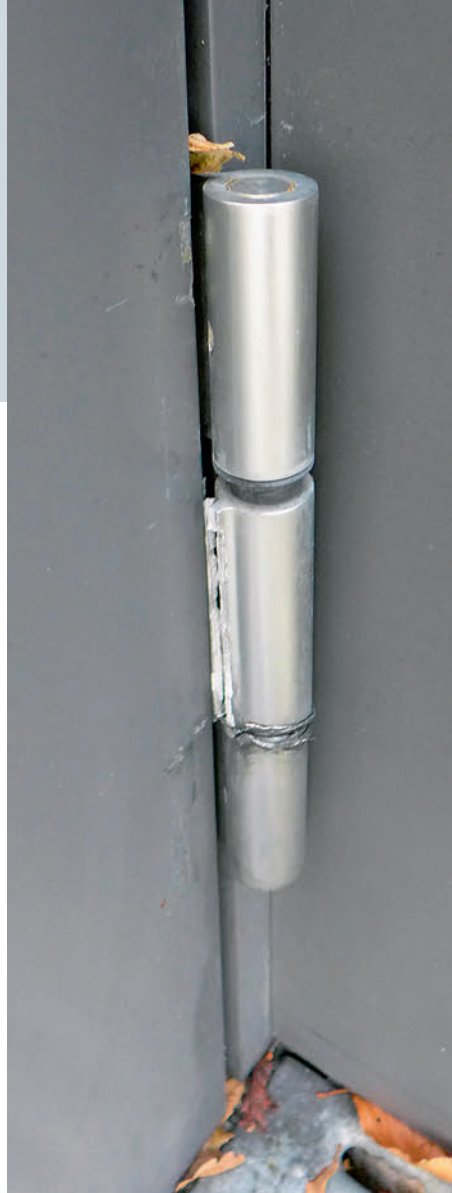
Alle Bänder sind erheblich abgenutzt und beschädigt. Toutes les charnières sont très usées et endommagées.
