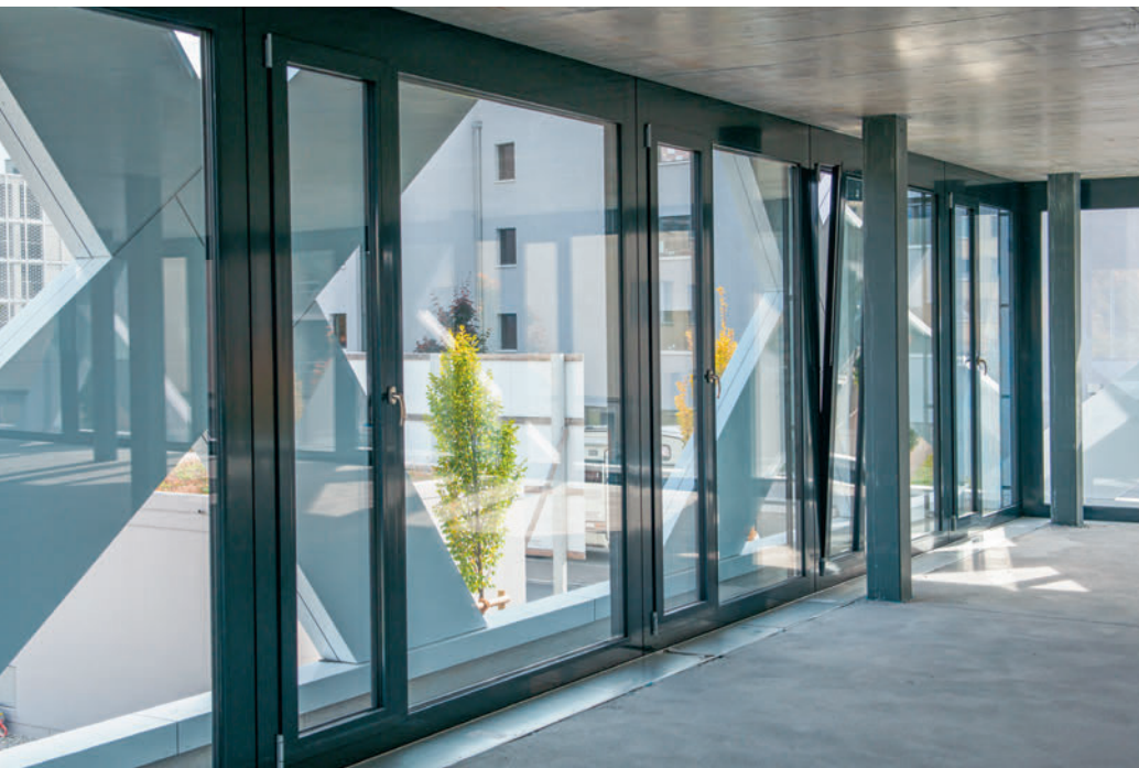
Bei der Elementfassade kam das System Gutmann S70+HW zur Anwendung. Spezielle Anforderungen stellte auch der Glaseinsatz, welcher ausschliesslich von innen erfolgte. Le système Gutmann S70+HW a été utilisé pour la façade. L'utilisation du verre s'accompagne d'exigences spéciales et les vitrages ont été posés uniquement de l'intérieur.
