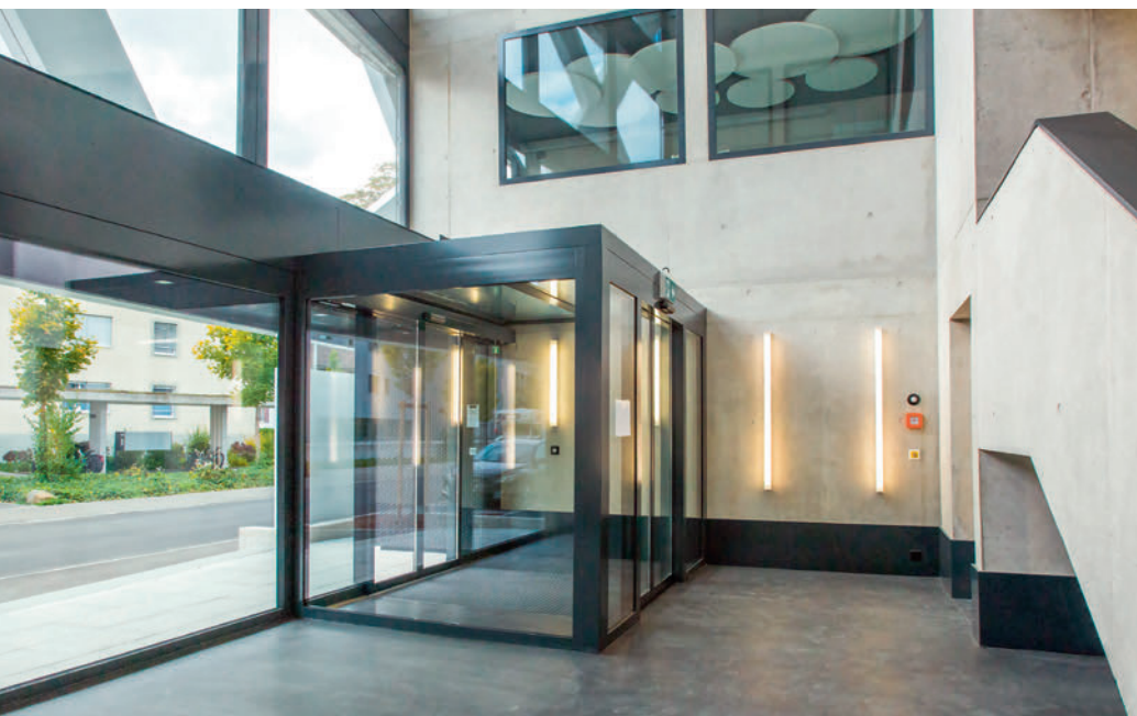
Haupteingang mit Windfang. Oben die über drei Stockwerke angelegten Brandschutzverglasungen. Entrée principale avec sas. Au-dessus, vitrages coupe-feu montés sur les trois étages.
