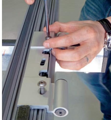
Das aus zwei Hauptteilen bestehende Band wird innert Kürze mit den Klemmankern verschraubt. Unten zu erkennen ist der Tragklotz mit integrierter Schraube für die Höhenverstellung sowie der Schieberegler im Langloch zur Anpassung des Anpressdrucks.
