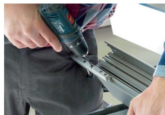
Mit nur einer Bohrlehre können alle Bohrungen für die Fixierung der Eckverbinder vorgenommen werden.
