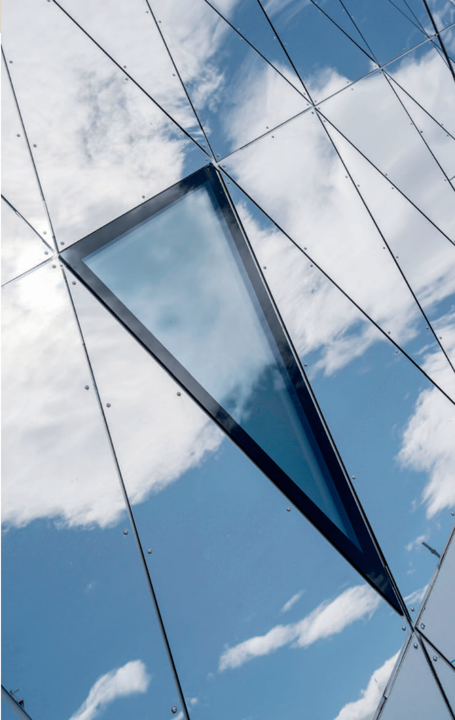
Detailansicht: Blechverkleidung mit integriertem Glaselement. Vue détaillée : revêtement de tôle avec élément vitré intégré.
