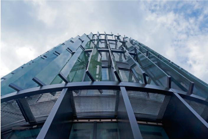
Die Fassade ist mit aussen vorgesetzten, lichtlenkenden Glaslamellen bestückt. Für den Unterhalt gewährt ein im Radius verlaufender Gitterroststeg den bequemen Zugang.
