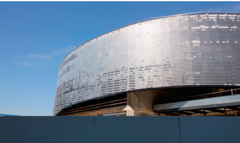
Das Gebäude weist die Besonderheit auf, im unteren Bereich überhängend zu sein.
