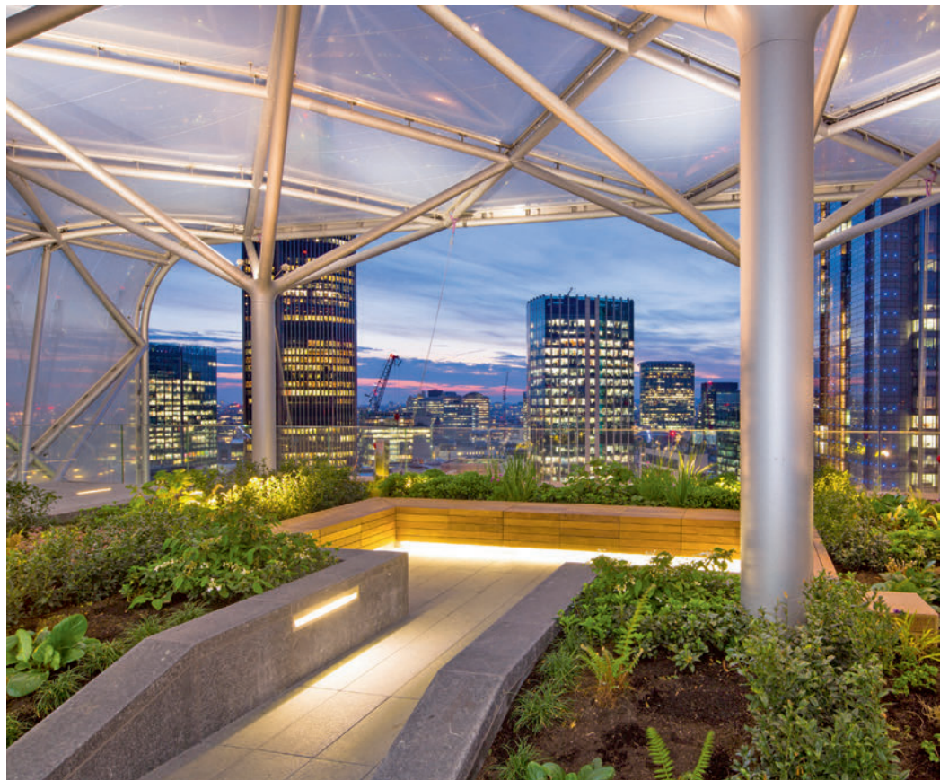
Gewisse Bauteile der Hüllenkonstruktion stammen aus dem 3D-Drucker. Certains éléments de construction de l'enveloppe ont été réalisés à l'imprimante 3D.
