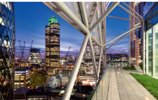
Die Tragkonstruktion aus Stahl führt über fünf Geschosse. La structure porteuse en acier traverse cinq étages.
