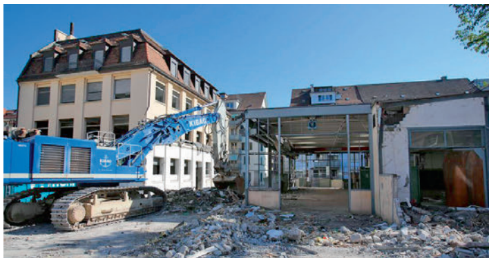
Abbruch der Produktionshalle in der Stadt Zürich.
