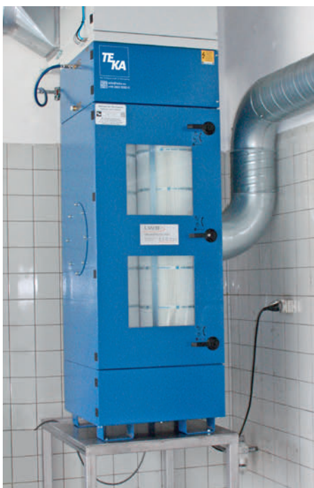
Die kompakte Absaug- und Filteranlage Filtercube ist platzsparend in einem Nebenraum untergebracht.
