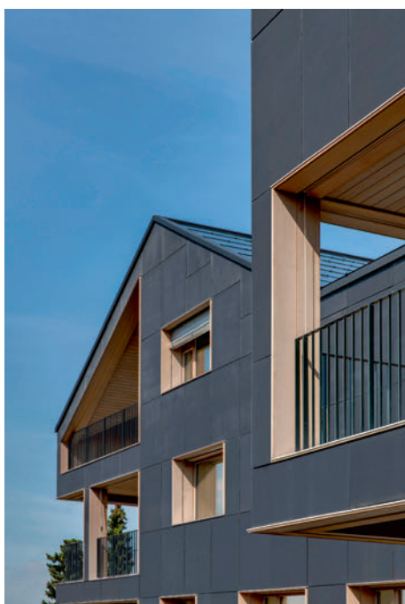
Détail de la façade avec loggias et fenêtres intégrées
