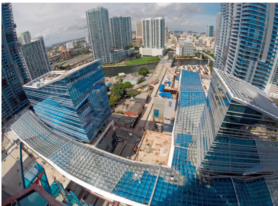
Climate Ribbon nennt sich das Stahlglasdach in Kombination mit der Beschattung. Le toit en verre et acier, associé à l'ombrage, est appelé Climate Ribbon.
