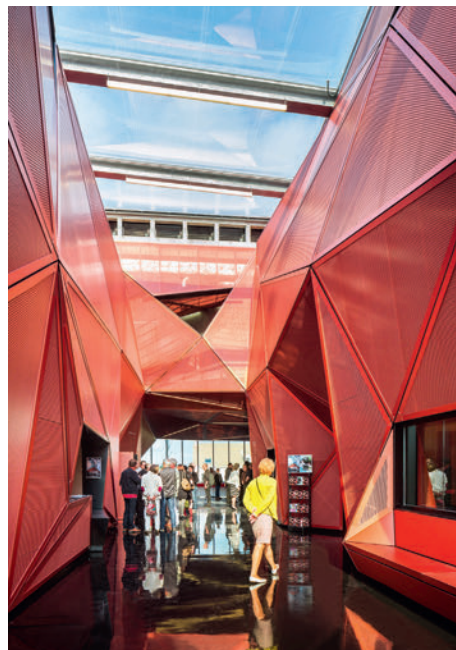
Im Innenraum nehmen die perforierten Paneele auch akustische Funktionen wahr. À l'intérieur, les panneaux perforés revêtent également une fonction acoustique.
