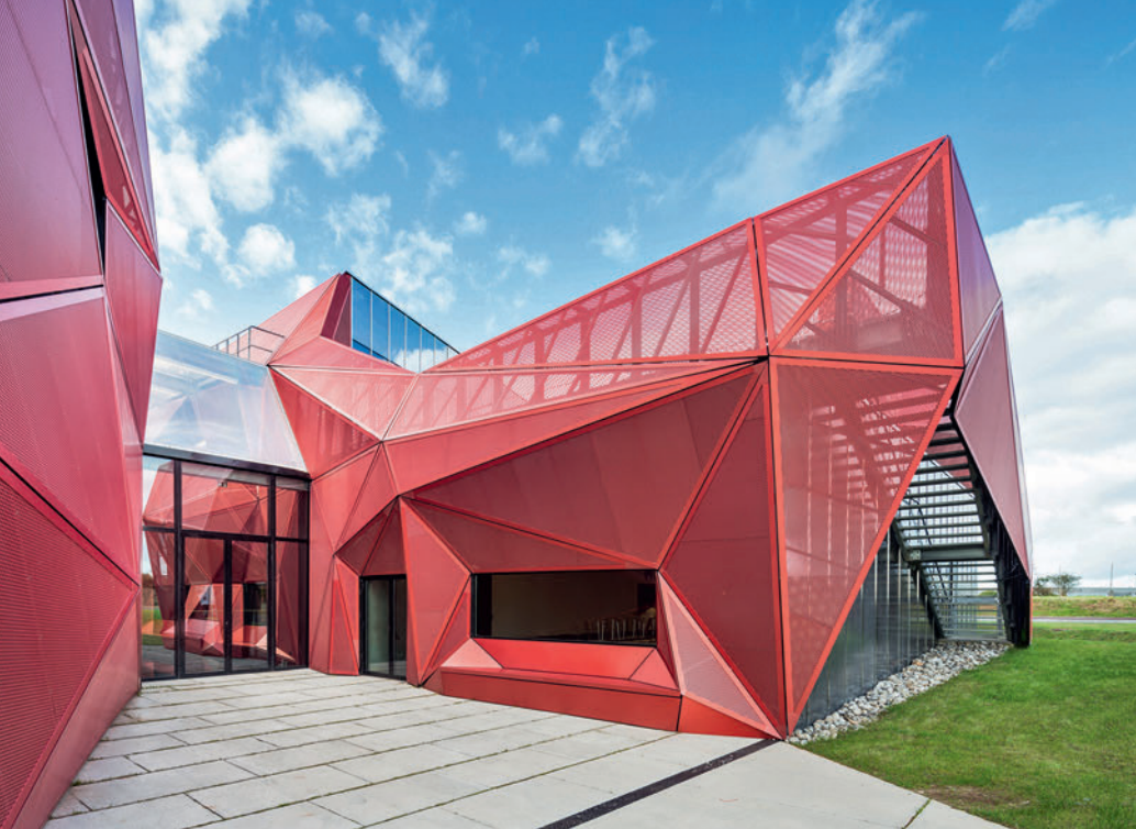
Dreieckförmige Aluminiumrahmen fassen die perforierten Bleche ein. Les tôles perforées sont enchâssées dans des cadres triangulaires en aluminium.
