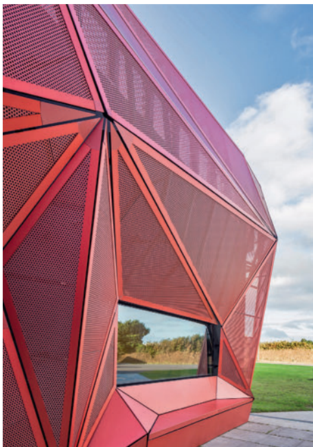
Dreiecke ermöglichen viele geometrische Formen. Les triangles permettent une grande variété de formes géométriques.
