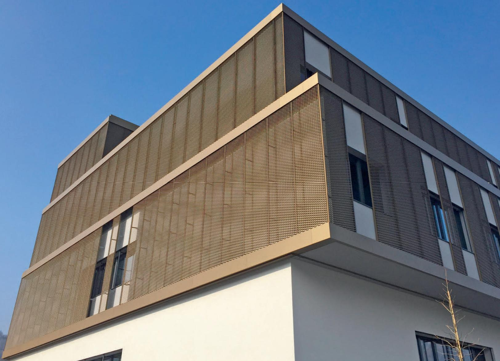
Produktionstechnisch galt es, die maximal 1200 mm × 4765 mm messenden Elemente mit kleinstmöglichen Masstoleranzen herzustellen.
