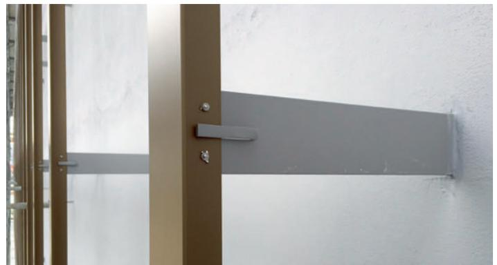
Die Streckmetallbleche sind auf der vertikal verlaufenden Unterkonstruktion befestigt.
