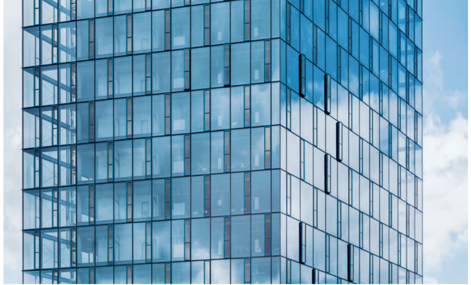
Energieeffizient: Die Glasfassade des neuen Automation Center der Firma Festo ist als Abluftfassade konzipiert und passt sich dank elektrochromer Fensterscheiben automatisch den Lichtverhältnissen an.
