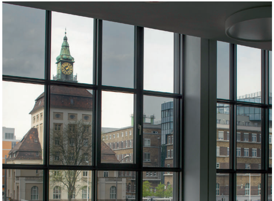
Gefärbter Blick: Die Fenster des Innovation Center der Firma Merck in Darmstadt enthalten Flüssigkristalle, die in Sekundenschnelle von Hell nach Dunkel schalten und umgekehrt.
