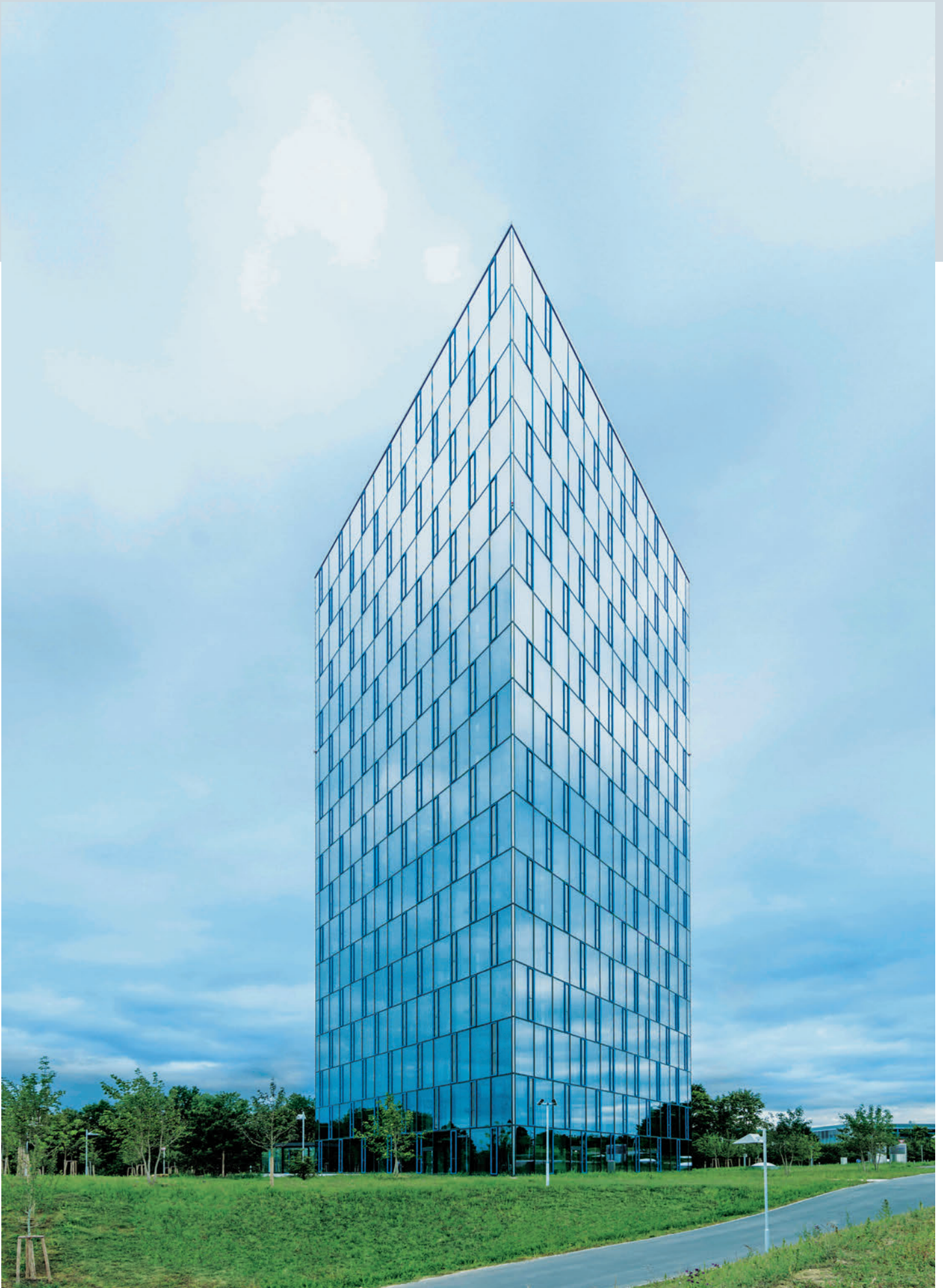
Vorzeigeprojekt: Die Gebäudehülle des neuen Automation Center der Firma Festo besteht komplett aus klimaaktivem Glas und lässt den Neubau modern und repräsentativ erscheinen. Bild: Festo
