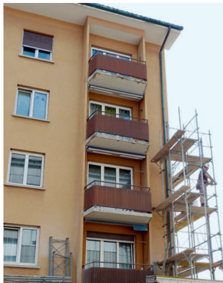
Teilansicht vor der Sanierung. Vue partielle avant la rénovation.
