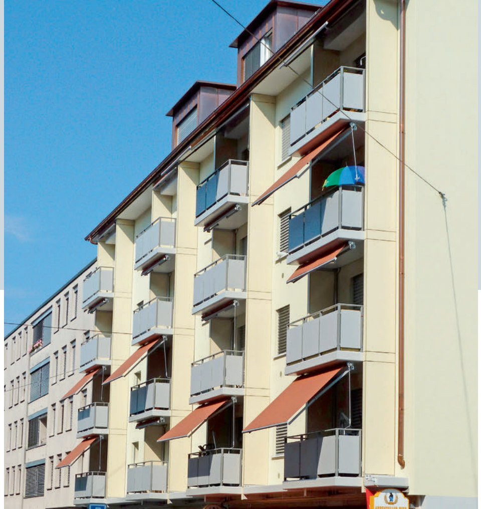
Auf der Front- und der Hofseite des Gebäudes sind insgesamt acht neue, hängende Balkonanlagen à je vier Einheiten angebracht worden. Frontseitig (Bild) Ausladung 1,30 m. Au total, huit nouveaux ensembles suspendus de quatre balcons chacun ont été placés à l'avant du bâtiment et côté cour. Projecture de 1,30 m sur la façade avant (photo).
