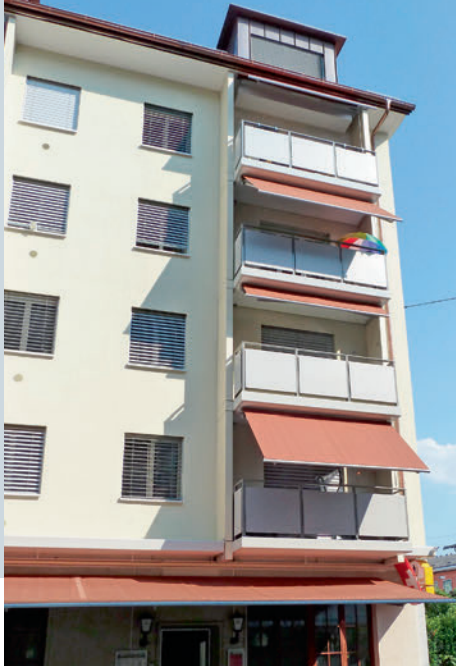
Teilansicht einer neuen Balkonanlage nach der Sanierung. Vue partielle d'un nouvel ensemble de balcons après la rénovation.
