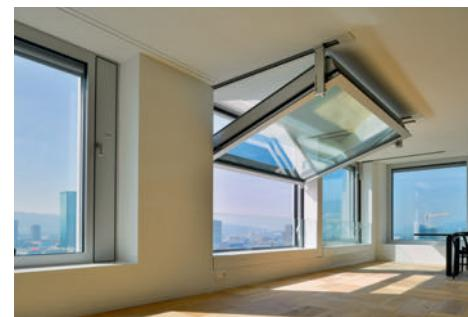
Zu drei Vierteln geöffnet: Die Kipp-Hub-Fenster sind bis zu 2,6 × 2,1 Meter gross und wiegen bis zu 450 Kilogramm.
