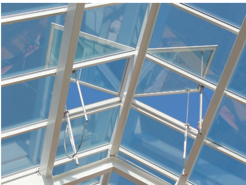
Dachlüftungsklappen am höchsten Punkt eignen sich besonders gut für die Entlüftung. Les aérateurs à clapets de toit placés au point le plus haut sont bien indiqués pour l'évacuation de l'air.
