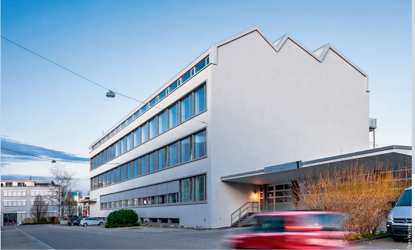
Die Fensterfronten des Geschäftshauses «Blätler Areal» sind im hochwertigen Aluminiumsystem Schüco AWS 75.SI gebaut.
