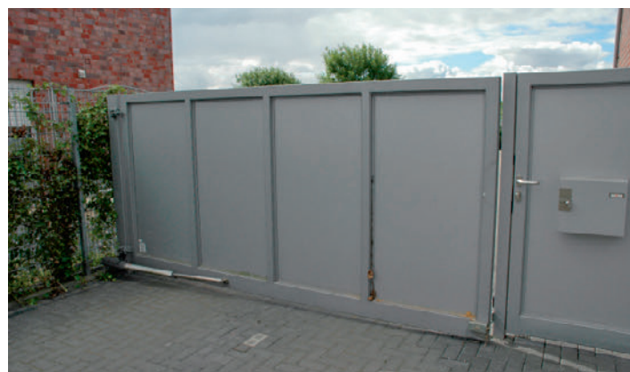
Drehtor mit geschlossener Füllung - hier müssen die Windlasten richtig berechnet werden. Portail coulissant opaque - les charges au vent doivent être calculées avec précision.
