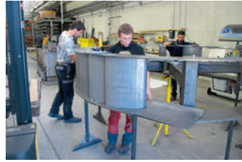
Bau der Innenseite des Rads. Costruzione della fascia interna della ruota
