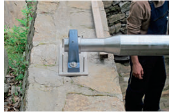
Montage der Kugellager. Montaggio dei cuscinetti.
