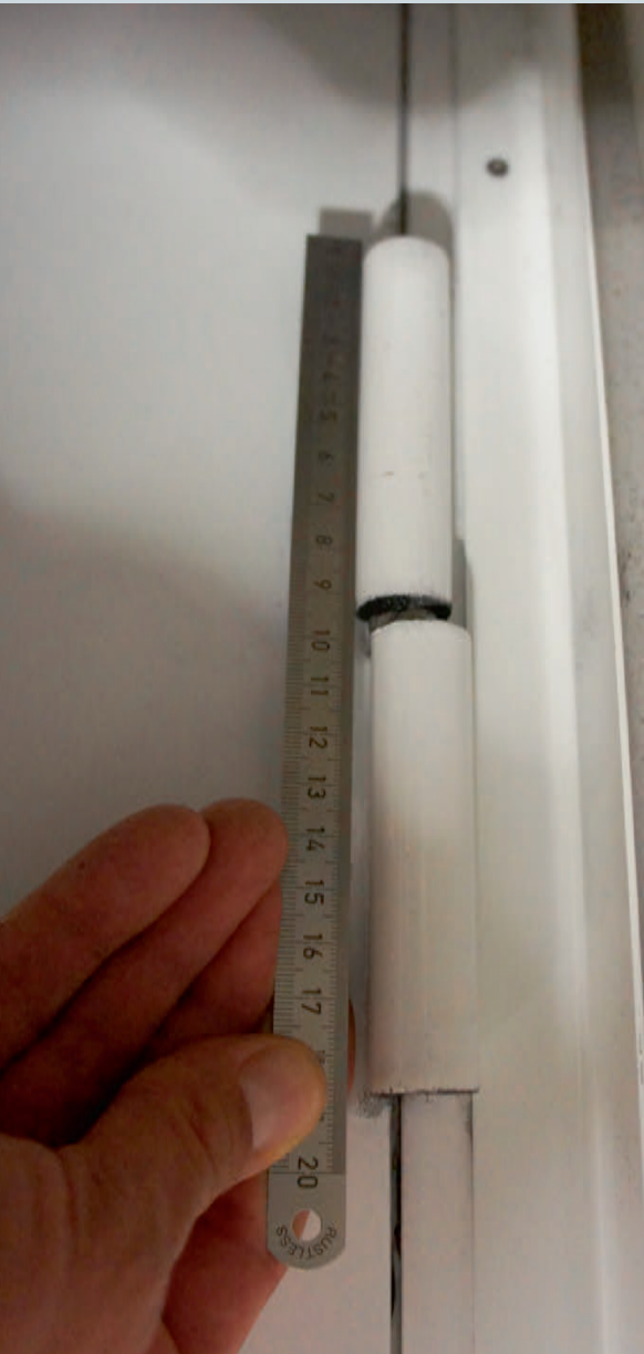
Bild 1: Anschweissband mit Versatz. Photo 1 : Paumelle avec déport
