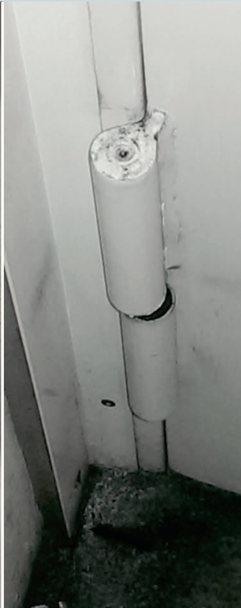
Bild 2: Sicht von oben: Anschweissband mit Versatz. Photo 2 : Paumelle avec déport
