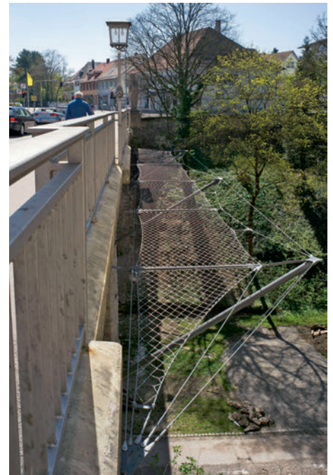
Drei Meter unterhalb der Brückenfahrbahn breitet sich das Webnet aus. ▶
