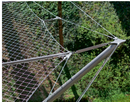
Maschenweiten von 20 × 20 cm verhindern, dass Abfall und verwehtes Material im Netz hängen bleiben.
