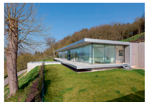
Auch die Fassadenecken sind als Ganzglasteilung konzipiert.
