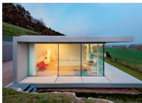
Boden- und Vordachstirnen sind aus Blech ausgebildet.
