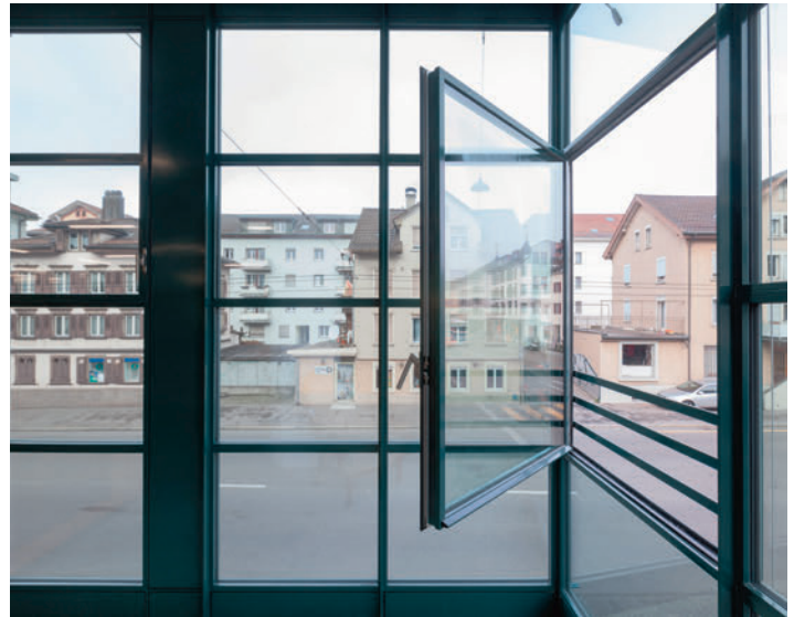
Mit dem schlanken Stahlprofilssystem sind Fenstergrößen von bis zu 800 auf 1600 mm möglich.
