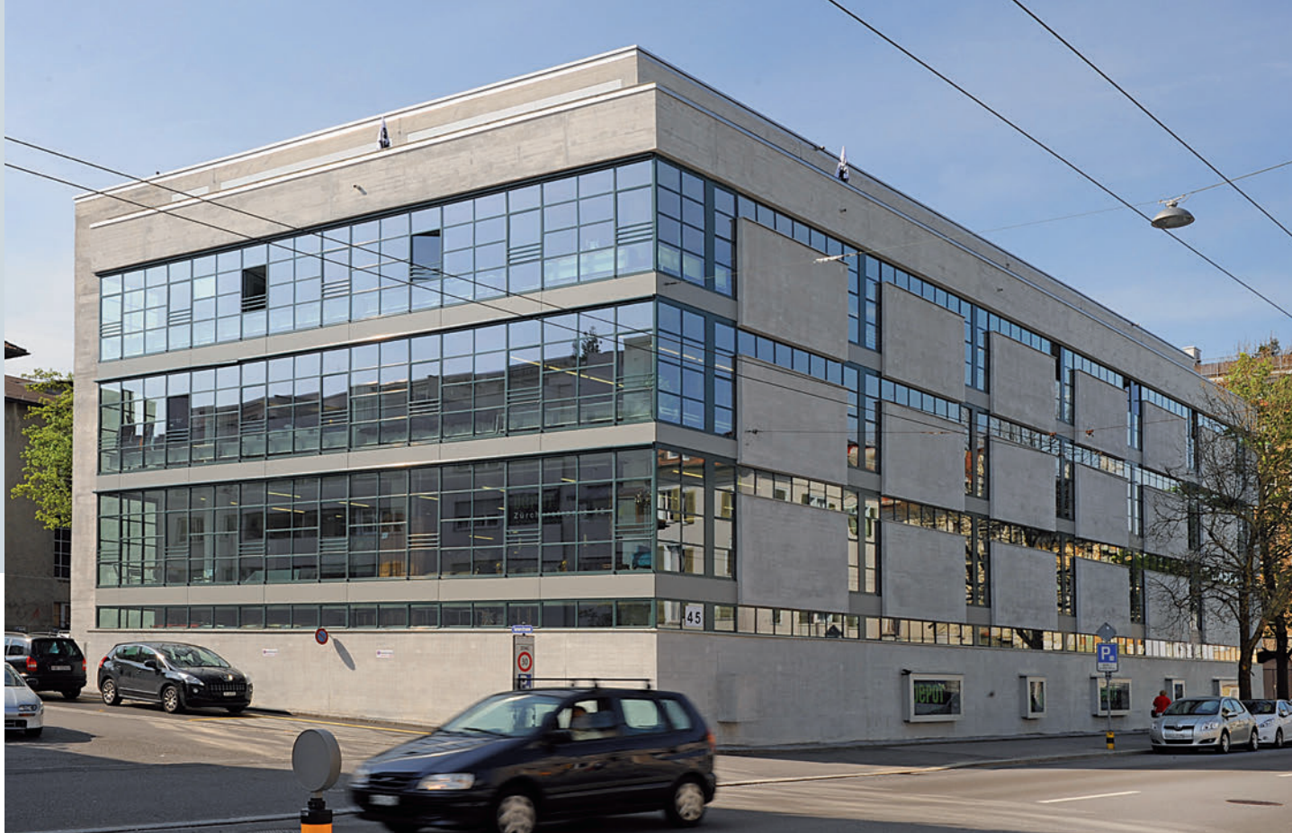
Der Wechsel von freistehenden Betonwänden mit Fensterbändern lockert die Fassadenansicht auf. L'alternance de murs en béton et de bandeaux vitrés égaie la façade.
