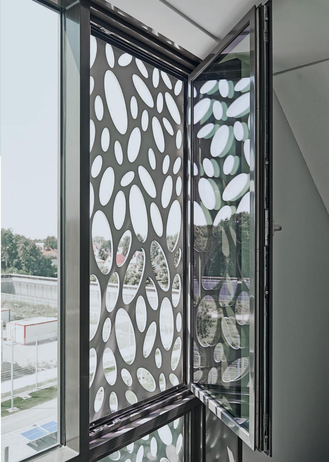
**Das Standardfenster besteht aus fest verglasten Feldern und einem Dreh-Kipp-Flügel. Dem Flügel ist ein Hartmangan-Blech vorgesetzt.**
