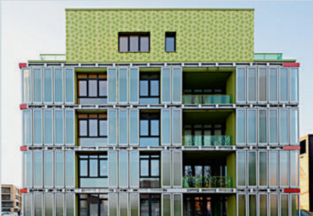
Das Wohnhaus «BIQ» in Hamburg mit der prototypischen Algenfassade.
