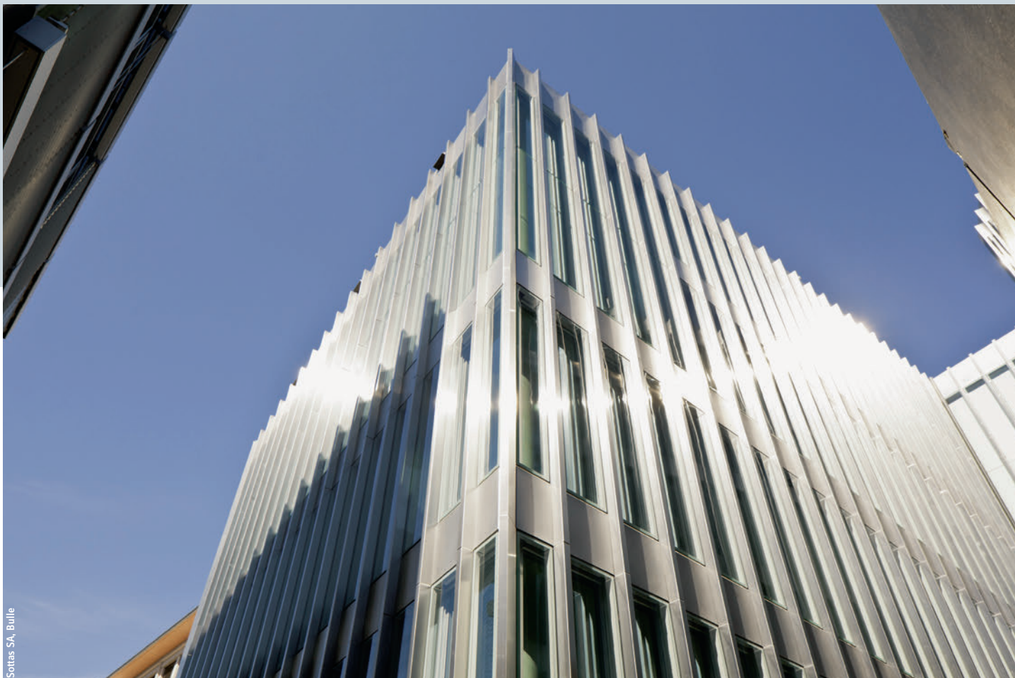
Am Gebäude der Edipresse Développement SA in Lausanne kam an der Fassade Weissglas zur Anwendung. Du verre blanc pour la façade du bâtiment d'Edipresse Développement SA à Lausanne.
