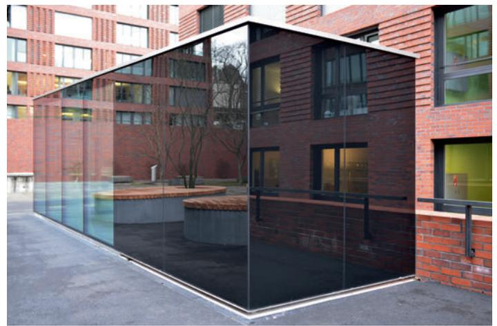
**Links der transparente und thermisch getrennte Teil. Rechts die schwarze, kalte Verglasung um die technischen Instrumente geführt.**
