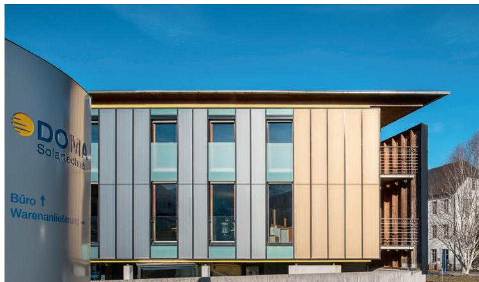
Fassaden sind auch ohne sichtbare Fugen realisierbar. Diese Variante ist vor allem in Konzepten anwendbar, in denen die Fenster das Fassadenbild prägen.
