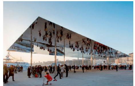
Das spiegelnde Dach am Vieux Port misst im Grundriss 46 × 22 Meter und steht auf acht filigranen Stahlstützen.
