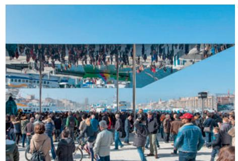
Für die Untersicht kamen hochglanzpolierte Edelstahlbleche von 1,5 mm Stärke zur Anwendung. Des tôles d'acier inox au poli spéculaire de 1,5 mm d'épaisseur ont été utilisées pour la sousface.
