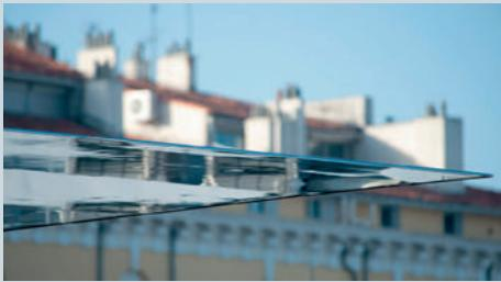
Die Dachstärke beträgt an den Randzonen lediglich 1,5 cm. Im Mittelfeld sind es rund 20 cm. L'épaisseur du toit n'est que de 1,5 cm au niveau des bords. Au milieu, elle est d'environ 20 cm.
