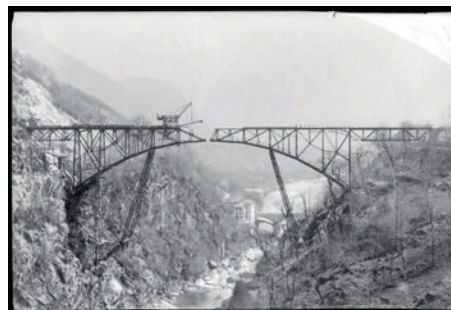
Die Montage dieser oft aus relativ leichten Elementen bestehenden Strukturen erfolgte mit Hilfe eines Derrickkrans. Spesso queste strutture, formate da elementi relativamente leggeri, venivano montate con l'aiuto di un «falcone».
