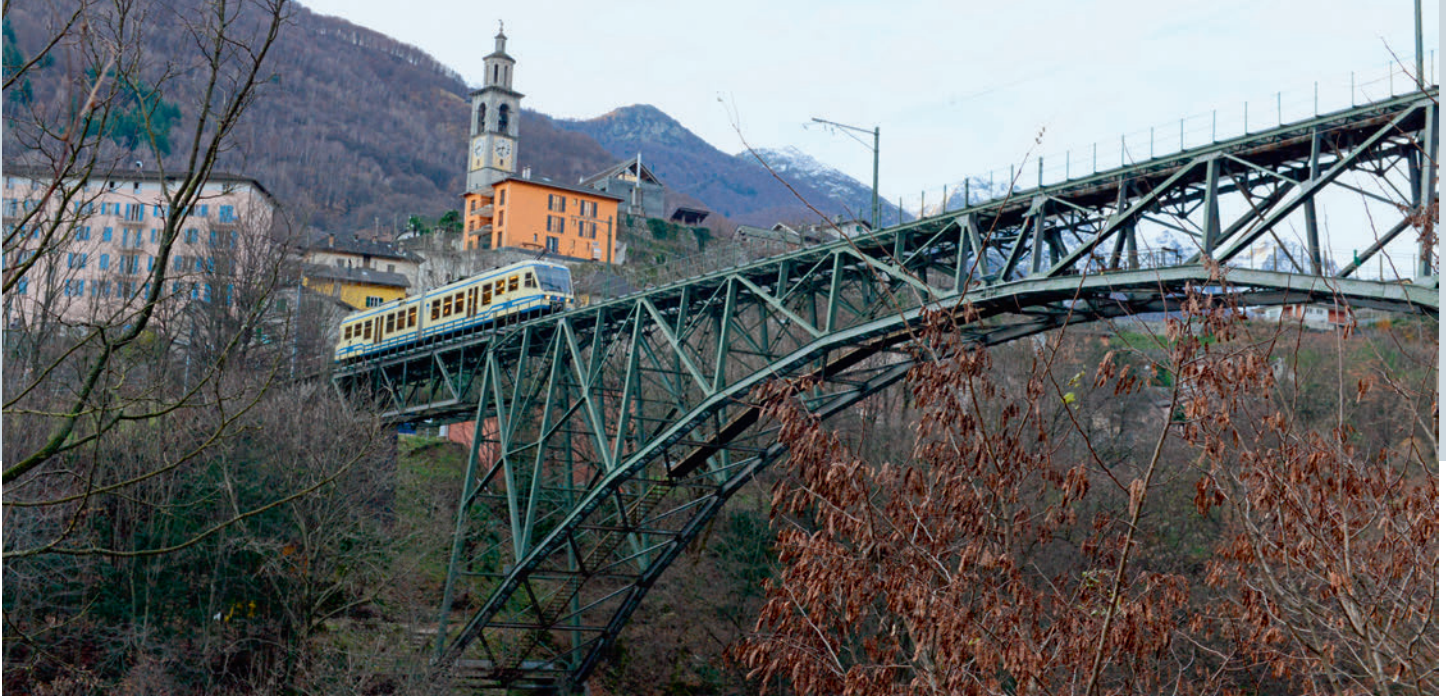
Die 1915 erbaute Isorno-Brücke der Centovalli-Bahnlinie bei Intragna. Die Spannweite beträgt 120 m, wovon 90 m den zentralen Teil der Brücke bilden. Il ponte sull'Isorno della Ferrovia delle Centovalli a Intragna costruito nel 1915. La lunghezza complessiva è di 120 m, di cui il tratto centrale del ponte misura 90 m.
