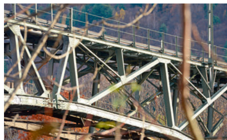
Die 1915 erbaute Isorno-Brücke der Centovalli-Bahnlinie bei Intragna. Die Spannweite beträgt 120 m, wovon 90 m den zentralen Teil der Brücke bilden. Il ponte sull'Isorno della Ferrovia delle Centovalli a Intragna costruito nel 1915. La lunghezza complessiva è di 120 m, di cui il tratto centrale del ponte misura 90 m.
