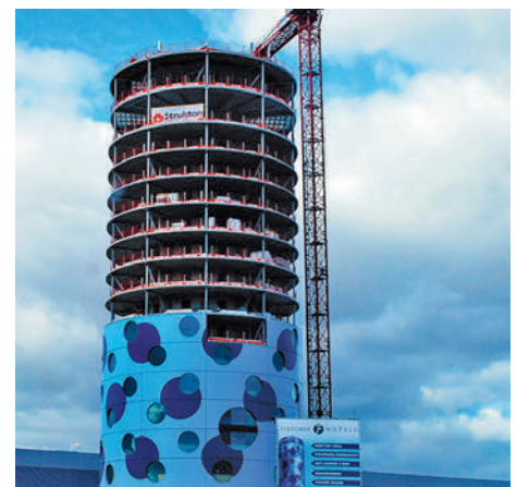
Doppelte punktgehaltene Glasfassade als Eyecatcher für ein Designhotel.
