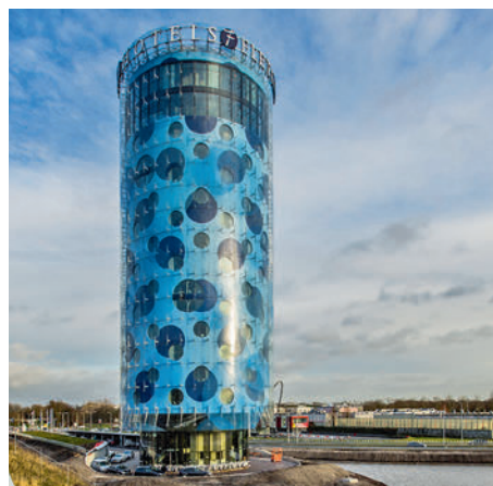
Doppelte punktgehaltene Glasfassade als Eyecatcher für ein Designhotel.
