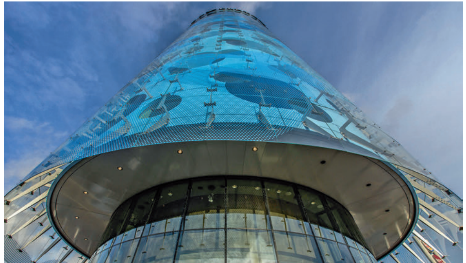
Doppelte punktgehaltene Glasfassade als Eyecatcher für ein Designhotel.
