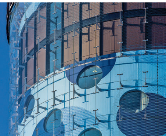
Die gewählten VSG-Gläser bestehen aus planen Vierecken, die im Siebdruckverfahren in verschiedenen Blautönen farblich beschichtet, anschliessend gebogen und laminiert wurden.
