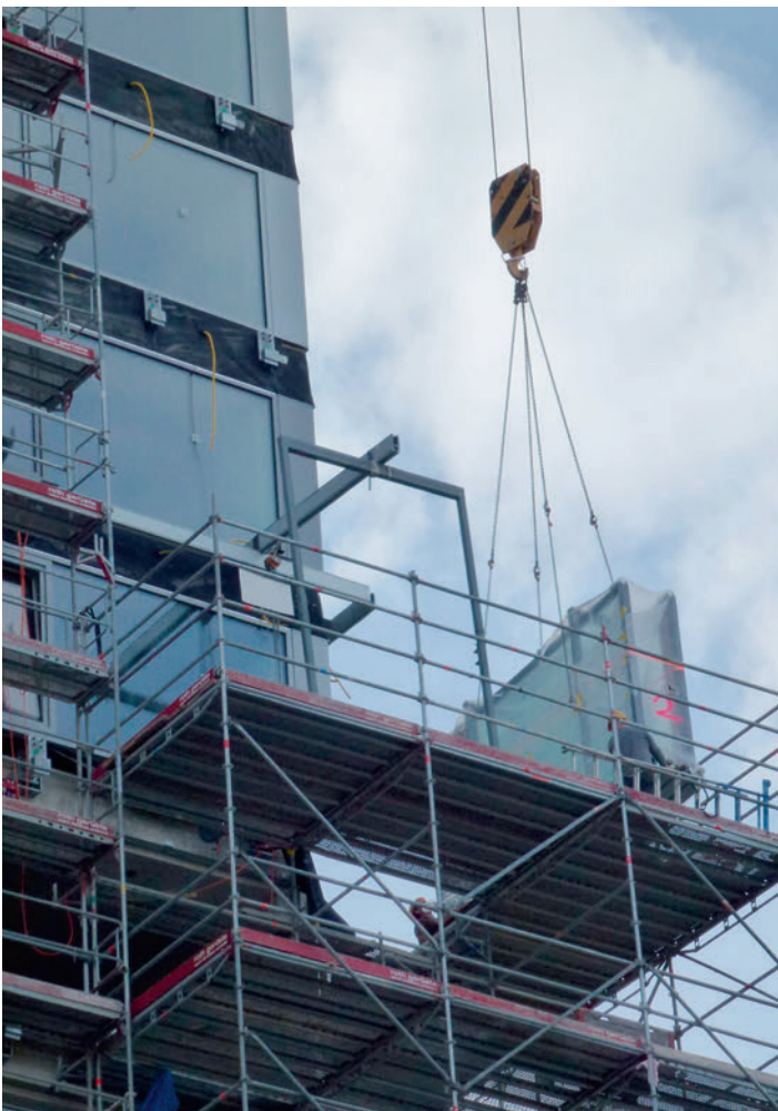
Mit dem Baukran werden die Elemente auf das Gerüstpedest gehievt. Ab hier kommt Eepos ins Spiel. La grue de chantier hisse les éléments sur l'estrade. Eepos entre ensuite en action.
