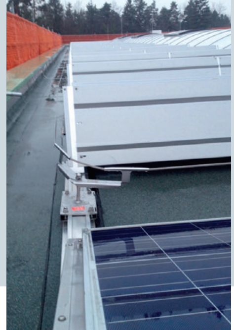
Das System ist für zehn Personen ausgelegt, wobei gleichzeitig maximal zwei Monteure in einem Feld angeschlagen sein dürfen. Le système est prévu pour dix personnes, sachant qu'il ne doit pas y avoir plus de deux monteurs ancrés dans un même champ simultanément.
