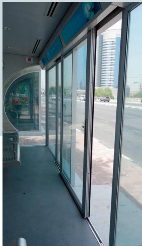
Der Zugang wird über eine automatisierte Schiebetür geregelt.
