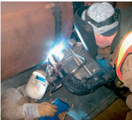
Bild 1: Von vier Stunden auf nur noch 20 Minuten pro Stoss reduziert das System TimeTwin Digital die Schweißzeit im Gaspipelinebau.
