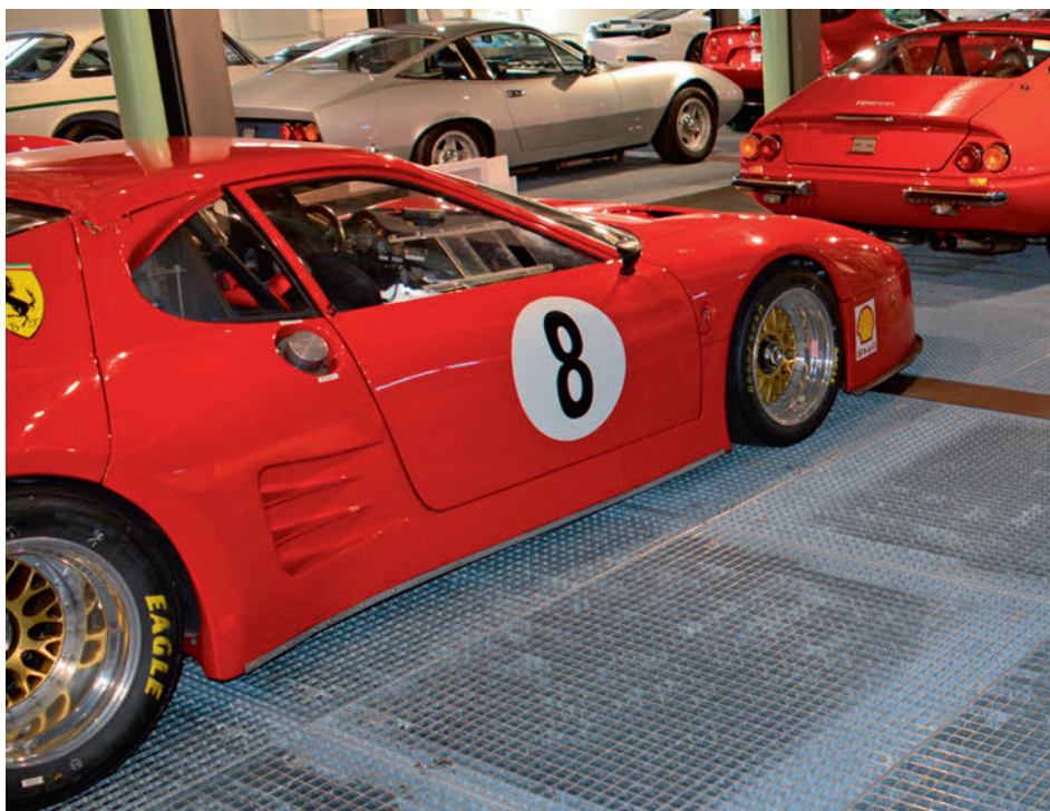
Die stählernen Bodenkonstruktionen von Autobau Romanshorn sind mit feuerverzinkten Gitterrosten belegt. Les sols en acier d'Autobau Romanshorn sont en grilles caillebotis zinguées à chaud.
