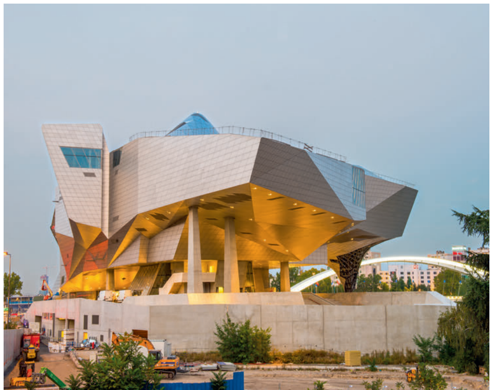
Die Rückseite des Gebäudes ist mit unzähligen Blechplatten belegt. L'arrière du bâtiment est recouvert d'un grand nombre de tôles.
