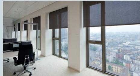
46 % der vertikalen Gebäudehülle sind hier transparente Flächen: ausgeführt mit einer leichten Sonnenschutzverglasung und einem effektiven innenliegenden Sonnenschutz.
