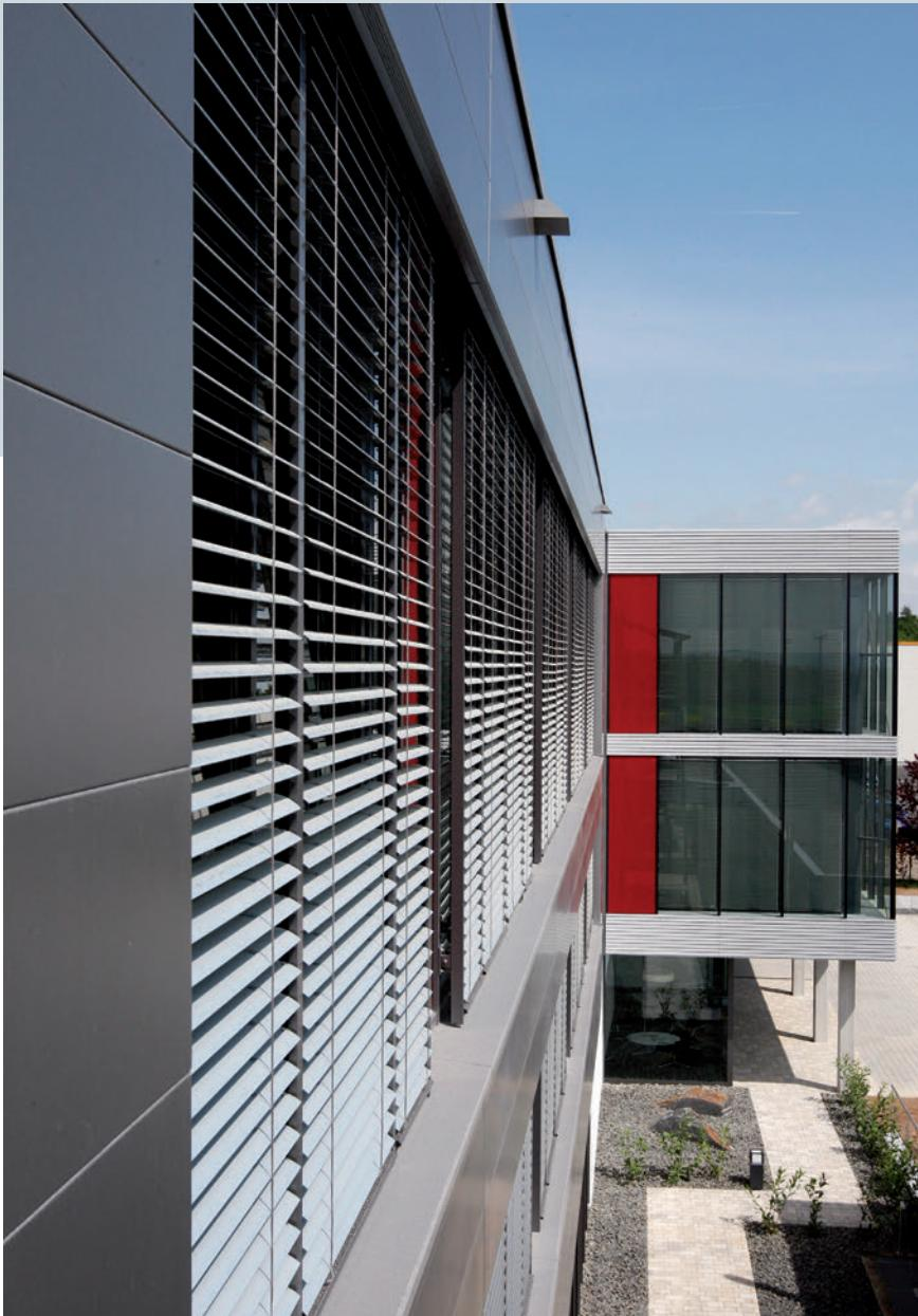
Raffstoren mit selektiven Lamellen absorbieren die UV- und Infrarot-Strahlung der Sonne weitgehend.
